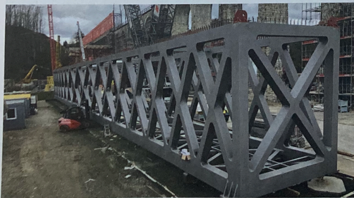
Bild 2: Große Blechelemente mit einem Gesamtgewicht von 340 t wurden am Boden für die Montage vorbereitet und anschließend in 20 m Höhe montiert.
