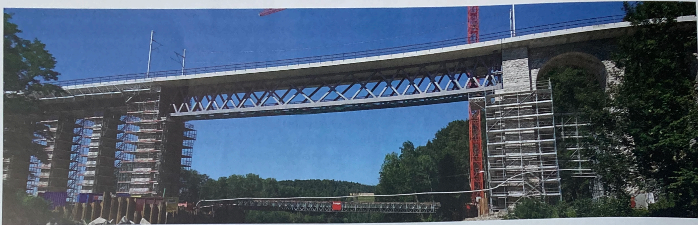
Bild 1: Erneuerung des Saaneviadukts mit Doppelspurausbau
