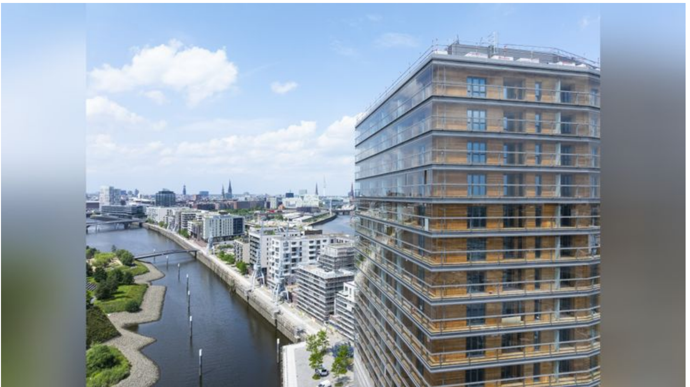
Roots Hamburg, das höchste Holzhybridgebäude Deutschlands. (Foto: Roots Hamburg, Daniel Sumesgutner)
